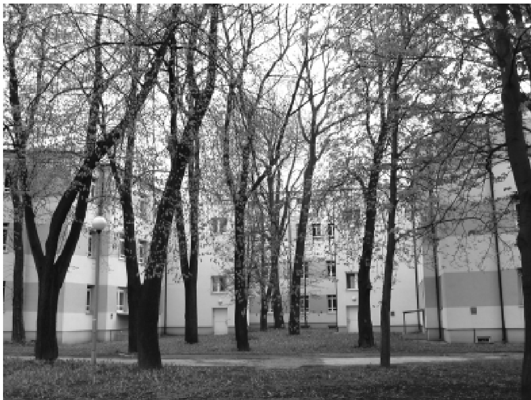
Fotografia 6. Pawilon 8, widok od tyłu, stan obecny Figure 6. Pavilion 8, back view, present state
